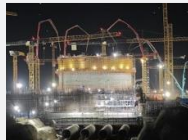
El Dabaa power plant | Egypt
