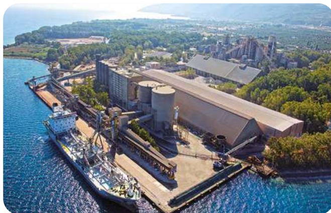
Cimenterie de Patras Grèce
