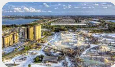
Cimenterie de Pennsuco, États-Unis
