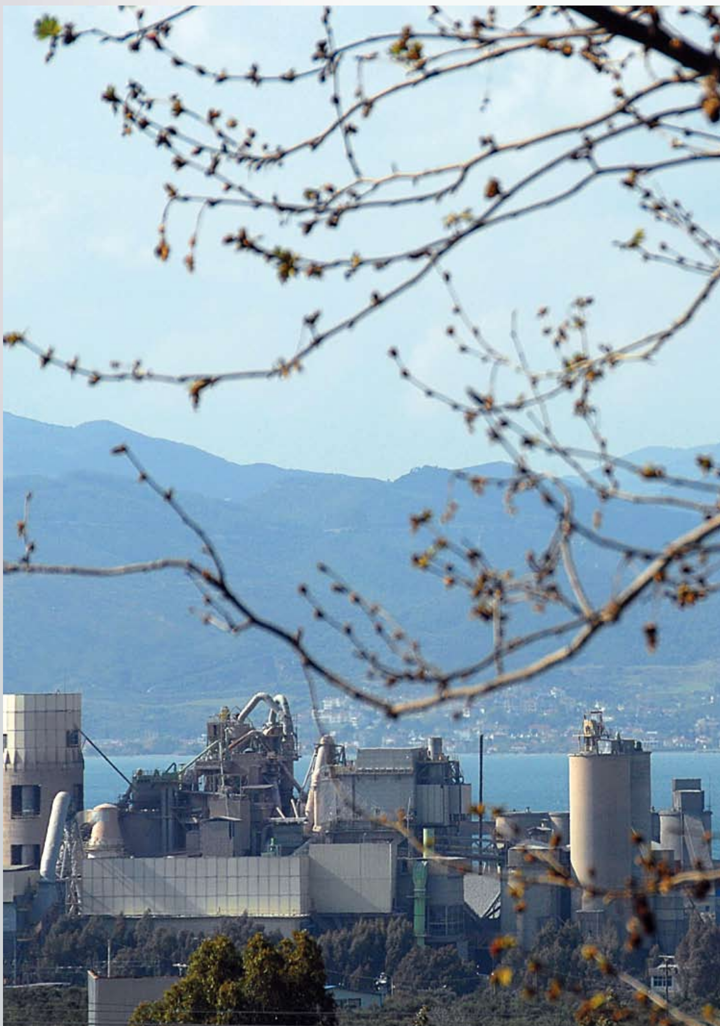
Εργοστάσιο Δρεπάνου, Πάτρα
