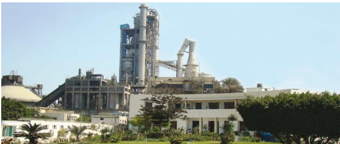
Εργοστάσιο Αλεξάνδρειας, Αίγυπτος
